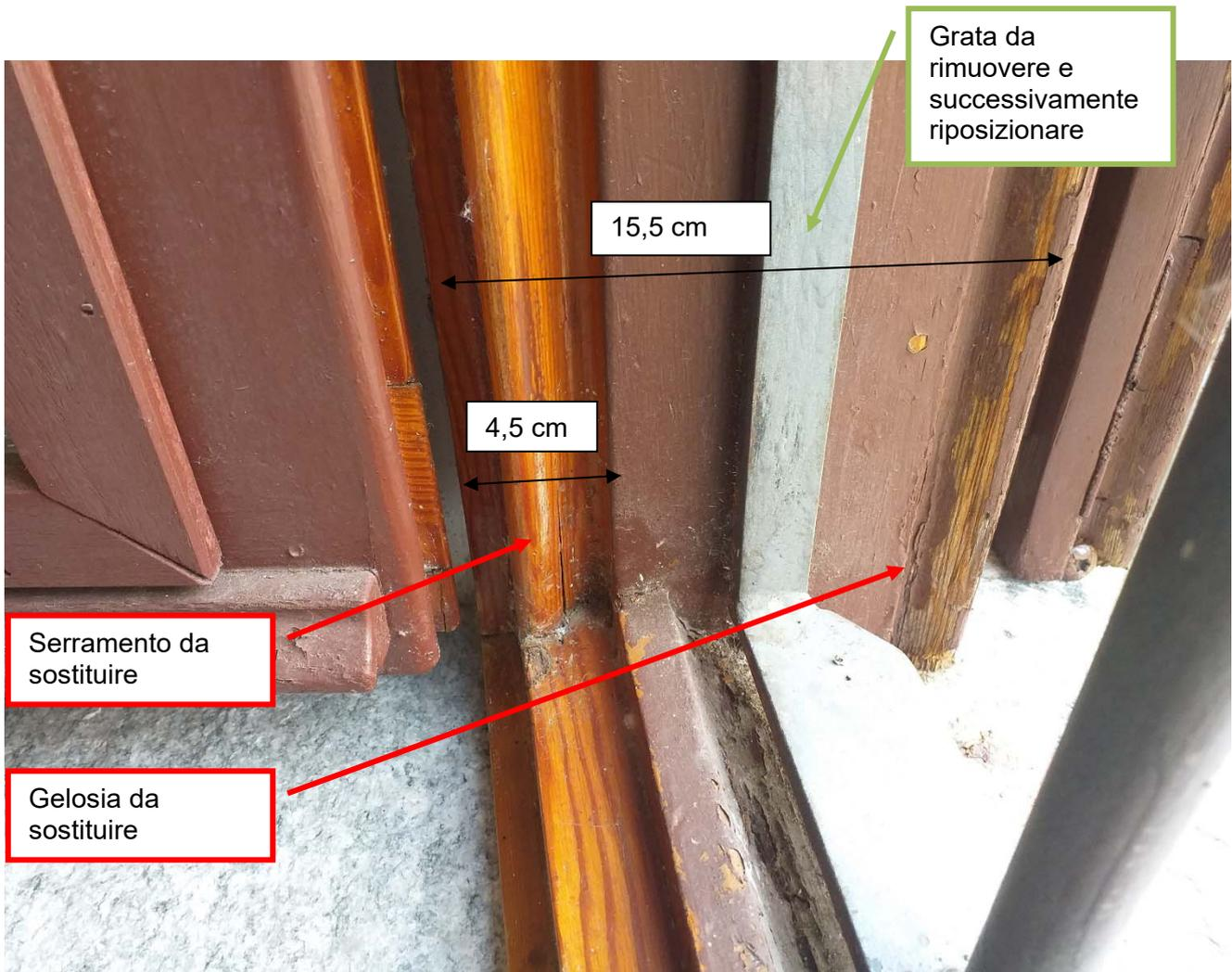
Foto interna (finestra e gelosia da sostituire)
