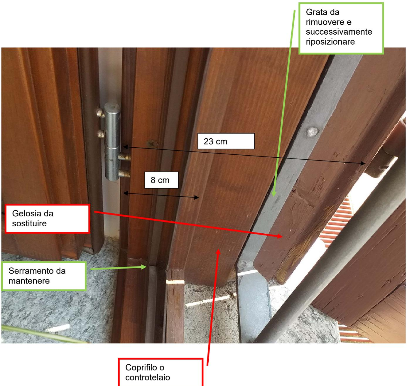
Foto interna (sola gelosia da sostituire)
