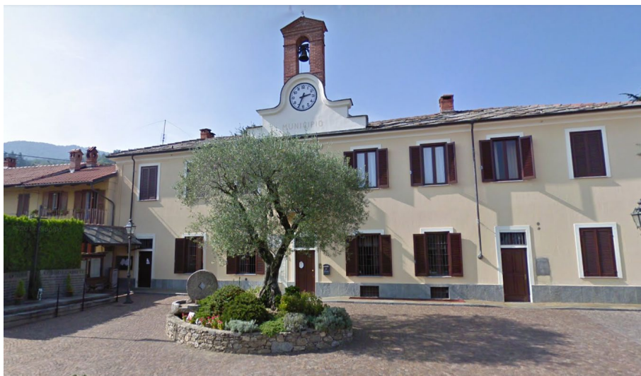
Foto 1 – Edificio oggetto d'intervento
