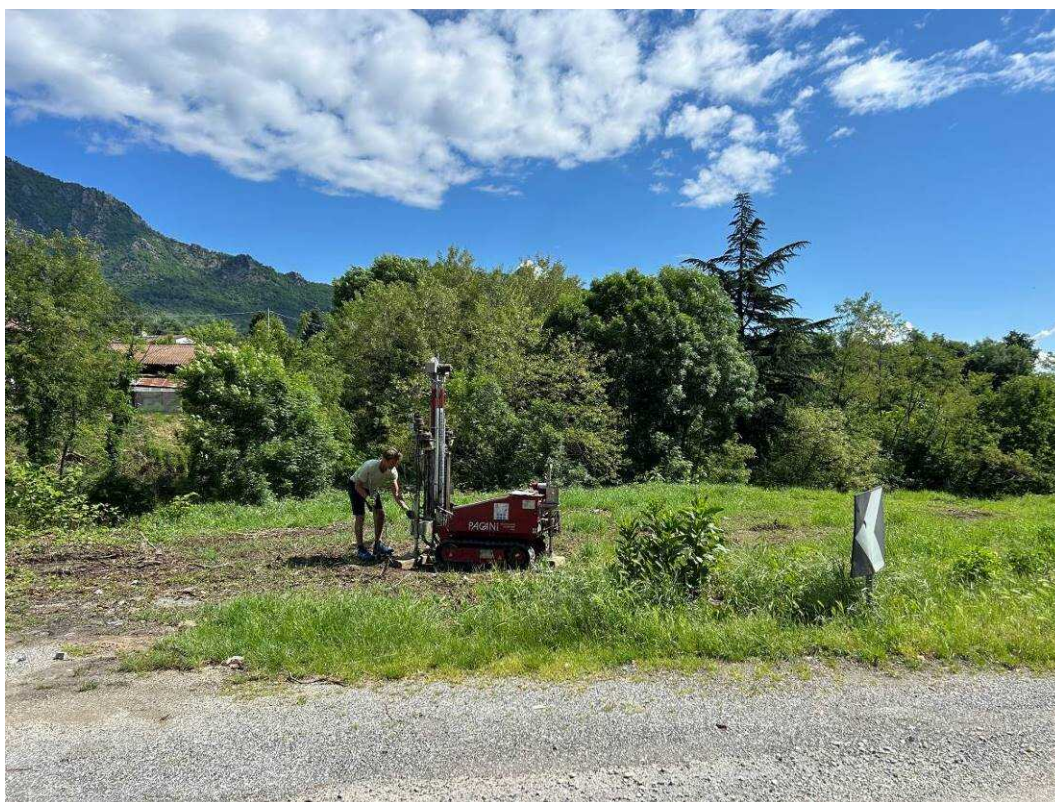
Foto 2 – L'esecuzione della prova penetrometrica DPSH 2
