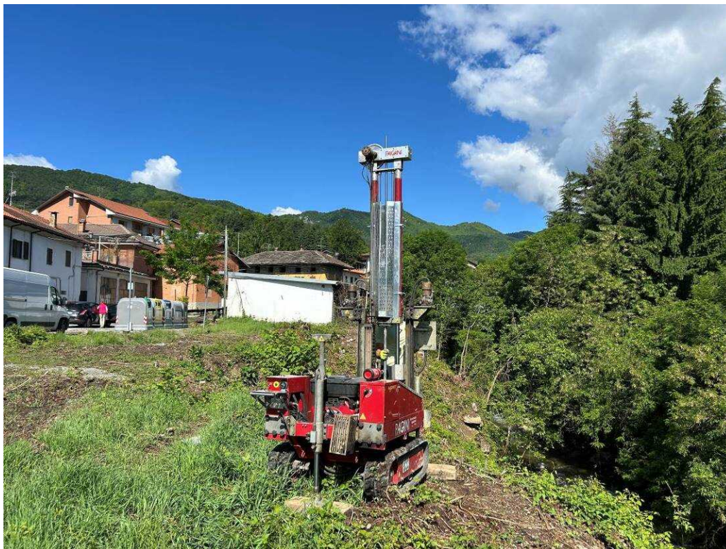
Foto 1 – L'esecuzione della prova penetrometrica DPSH 1
