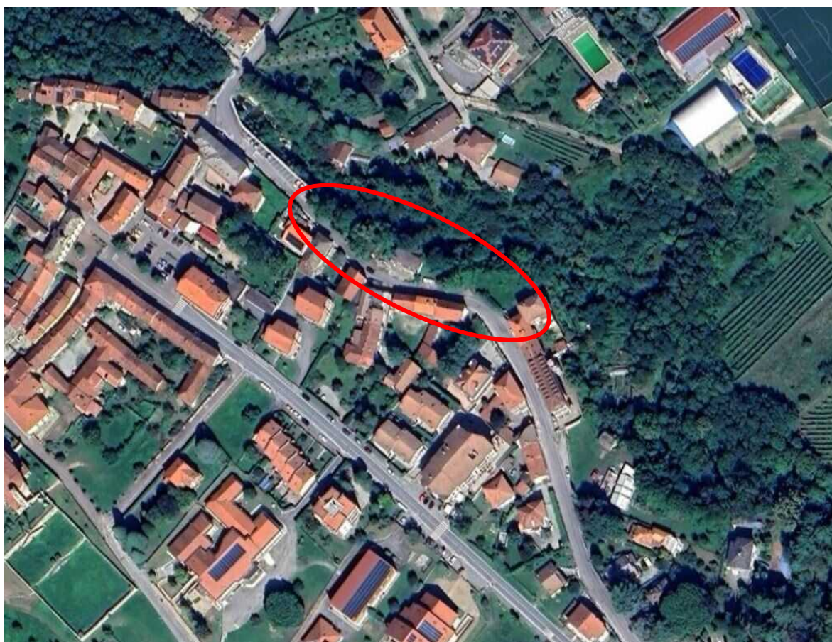
Figura 1 – ubicazione sito di intervento su stralcio Ortoimmagine.
