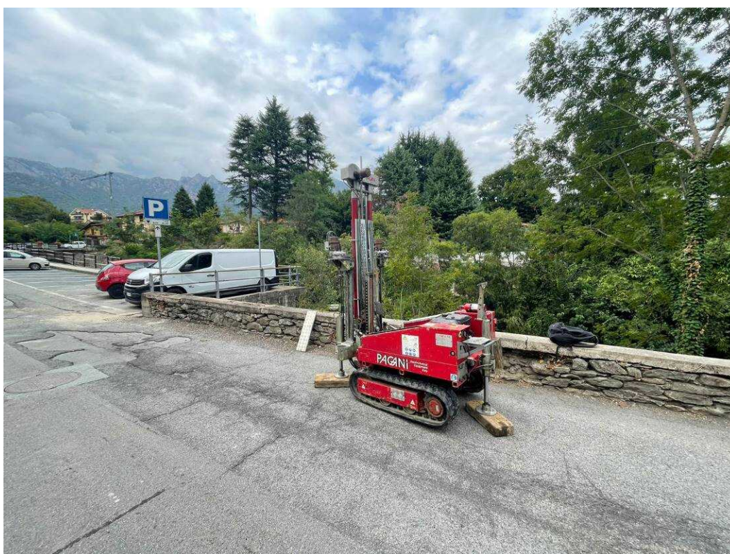
Foto 4 – L'esecuzione della prova penetrometrica DPSH 4
